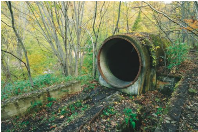
風洞の排気扇風機設置口の外観
