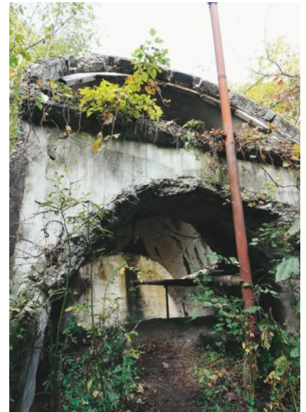
風洞斜坑外観
